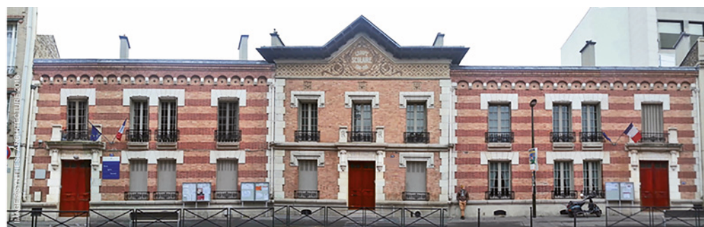
■ La façade historique sera conservée et bénéficiera d'un ravalement à sec.
