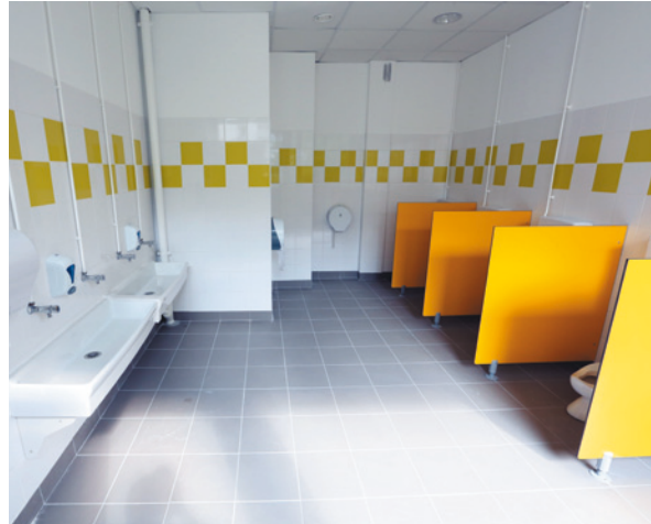
■ Le bâtiment du Vieux-Pont a été entièrement réhabilité et adapté aux besoins des nouveaux utilisateurs. Ici les nouveaux sanitaires.
