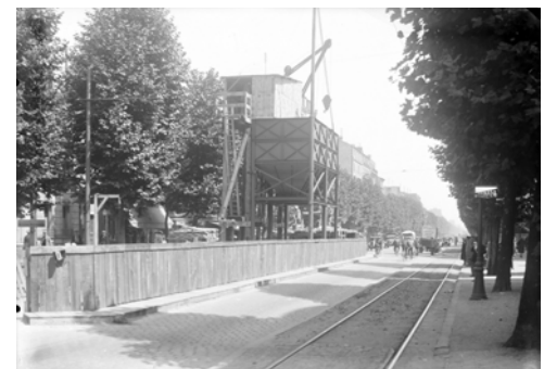
■ Travaux de la station Billancourt.
