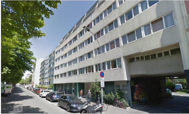
Façade actuelle du FTM « Meudon » à Boulogne
