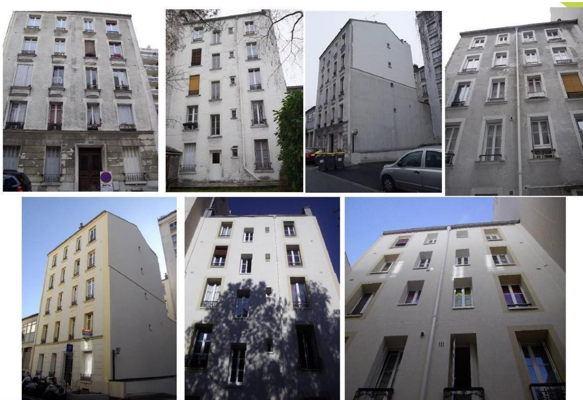
Immeuble dégradé de l'OHQ avant et après réhabilitation
