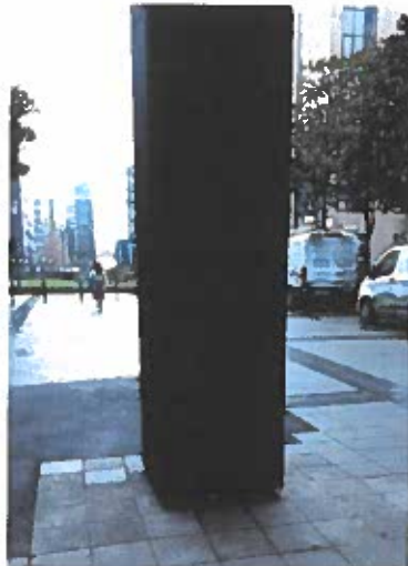
Poteau faisant l'objet d'un empiétement sur la servitude de passage.
