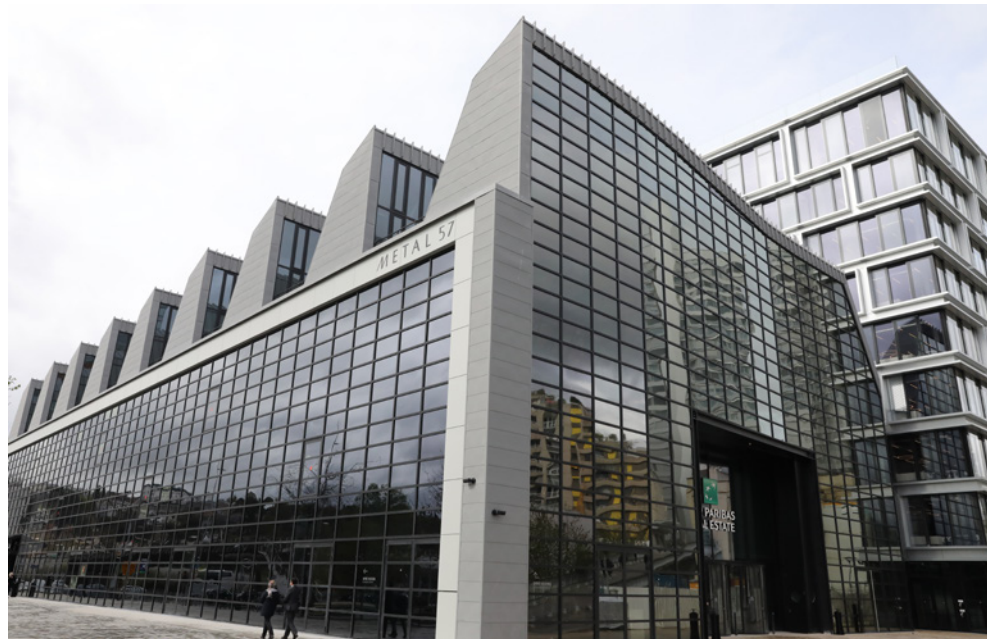
■ La façade a gardé la structure originelle imaginée par Vasconi avec ses fameux sheds, témoins du passé industriel du site.
