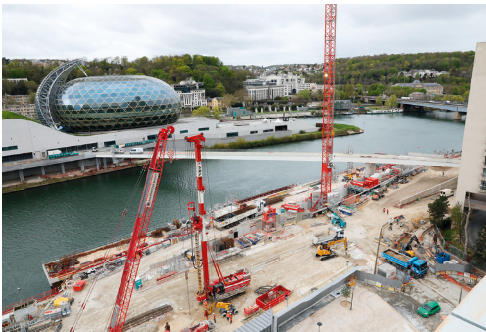
■ Vue d'ensemble des travaux.
