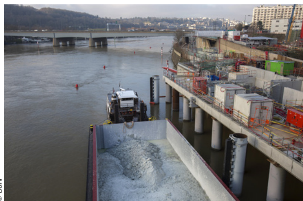
■ La barge accostée à l'estacade pour l'évacuation des déblais.
