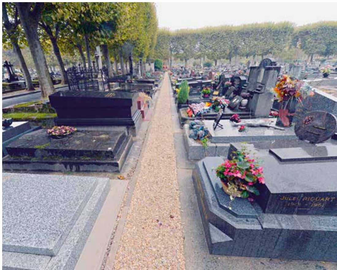
■ Exemple de rénovation dans une contre-allée. Le sol a été creusé puis de nouveau aplani et recouvert de gravier.
