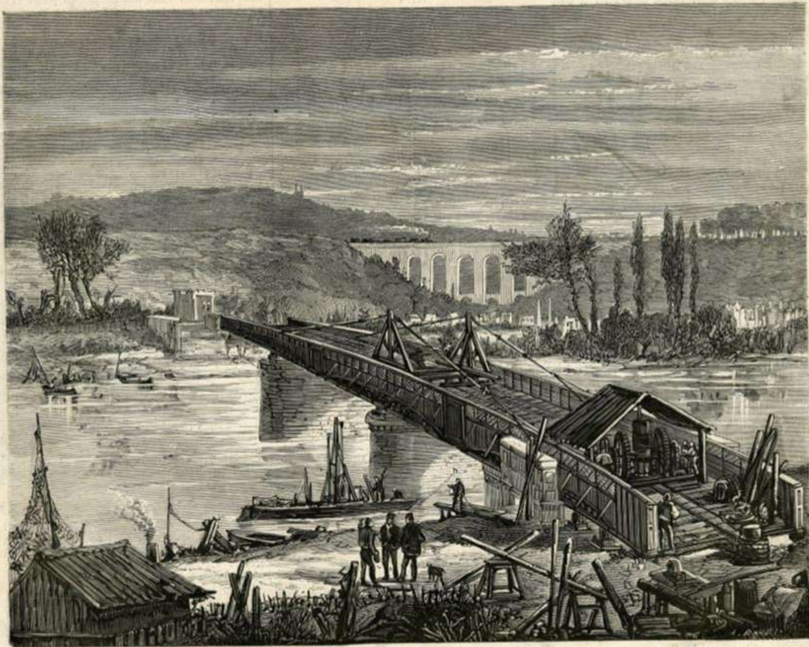
AUTOUR DE PARIS. — Reconstruction du pont de Billancourt. — Pose du tablier de la rive droite. — (D'après nature, par M. F. Gillier.)
