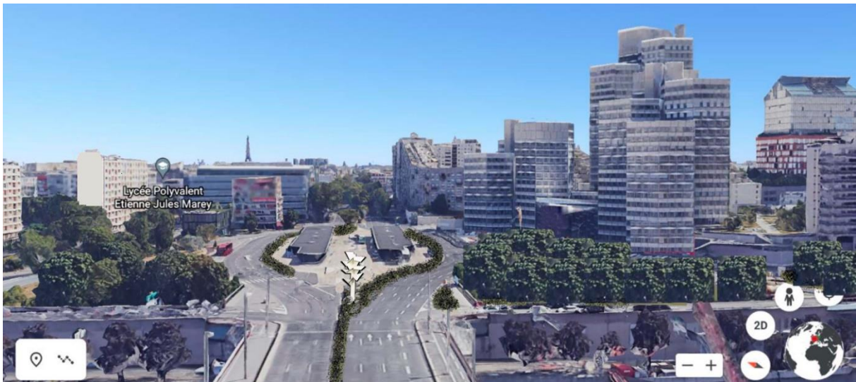
Pont de Sèvres (après)
